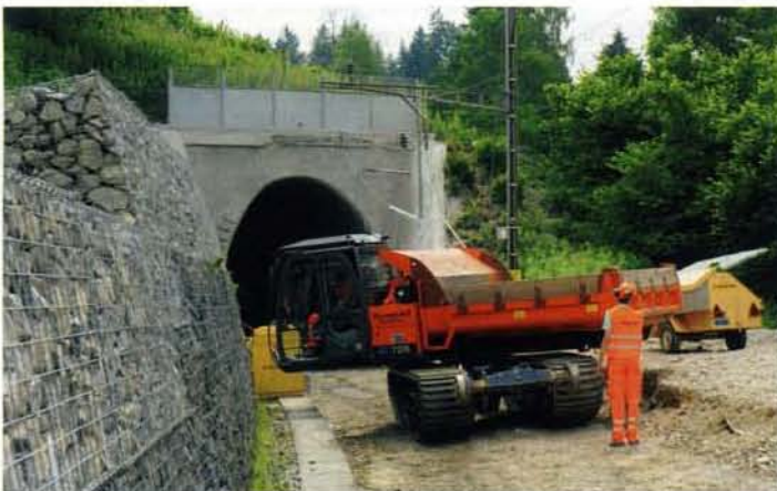
Der Raupendumper mit 6,5 t Nutzlast und Normalspurfahrwerk am 4. 7. 2012 vor dem Nordportal des Wilzingen-Tunnels.
