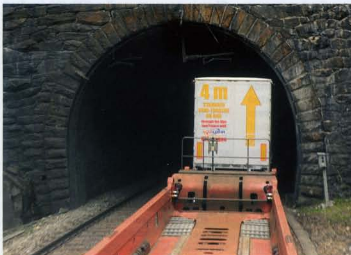
Der Testzug verlässt einen Tunnel auf der Gotthard-Nordrampe am 24.10.2012. Fotos: J.D. Lüthard
