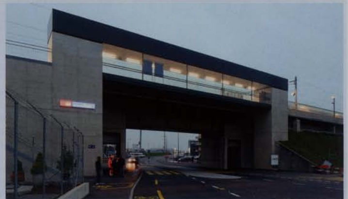
Die neue Haltestelle Fribourg/Freiburg Poya, 3.12.2014. Foto: SBB La nouvelle halte de Fribourg/Freiburg Poya, 3.12.2014.
