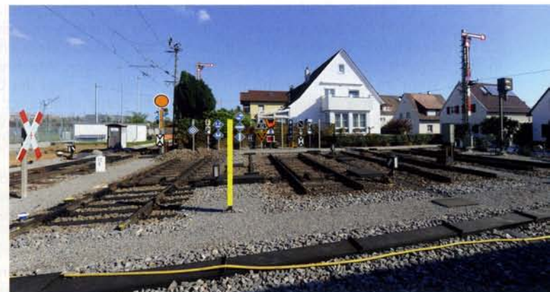
Die Aussenanlage mit Signalen und Weichen.
