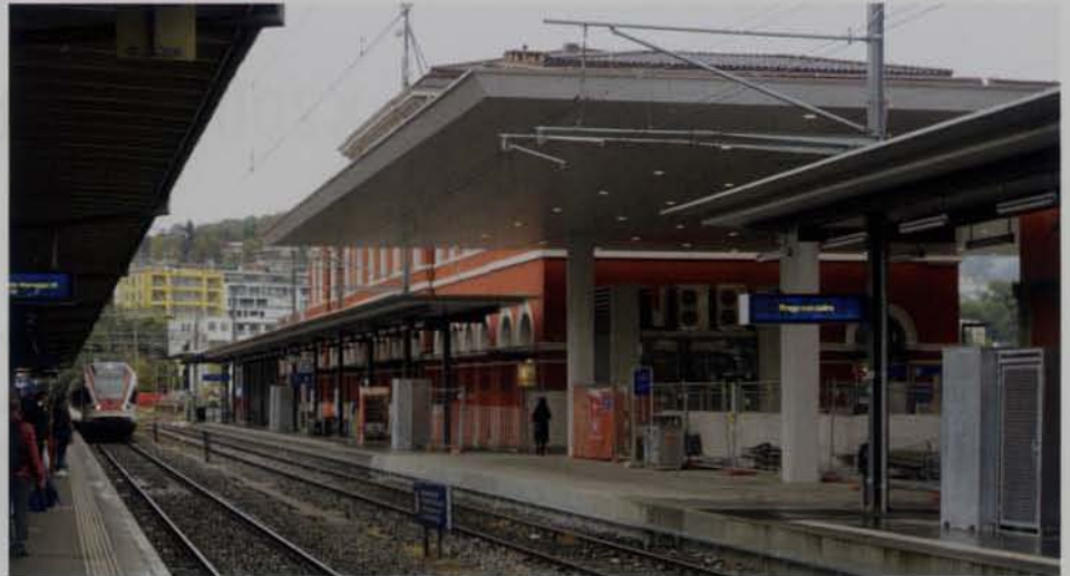
Lugano: überdachter Bereich südlich des Aufnahmegebäudes mit einfahrendem RABe 524 als S10 Bellinzona–Albate-Camerlata. 14.10.2016. Foto: S. Frei
