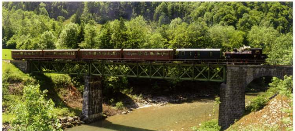
Die 68 m lange Sporeneggbrücke bei Streckenkilometer 31,73, welche durch Hochwasser an Pfingsten 1999 einstürzte. Auf der Brücke die Uh 102 mit dem Post- und vier Spantenwagen.
