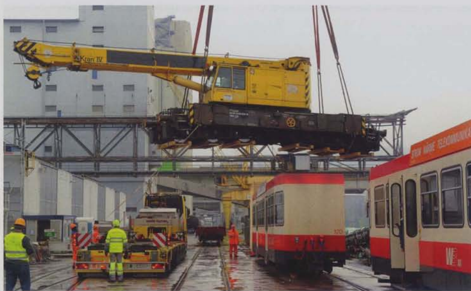
Der Vanomag-Kran IV (Gottwald, 112 t, Tragfähigkeit 45 t) VTmaass 99 85 9219 024-8 wurde am 30.4.2021 im Auhafen über die früheren WB-Fahrzeuge hinweg zum Transport via Rotterdam nach Ägypten verladen. Foto: J.D. Lüthard
