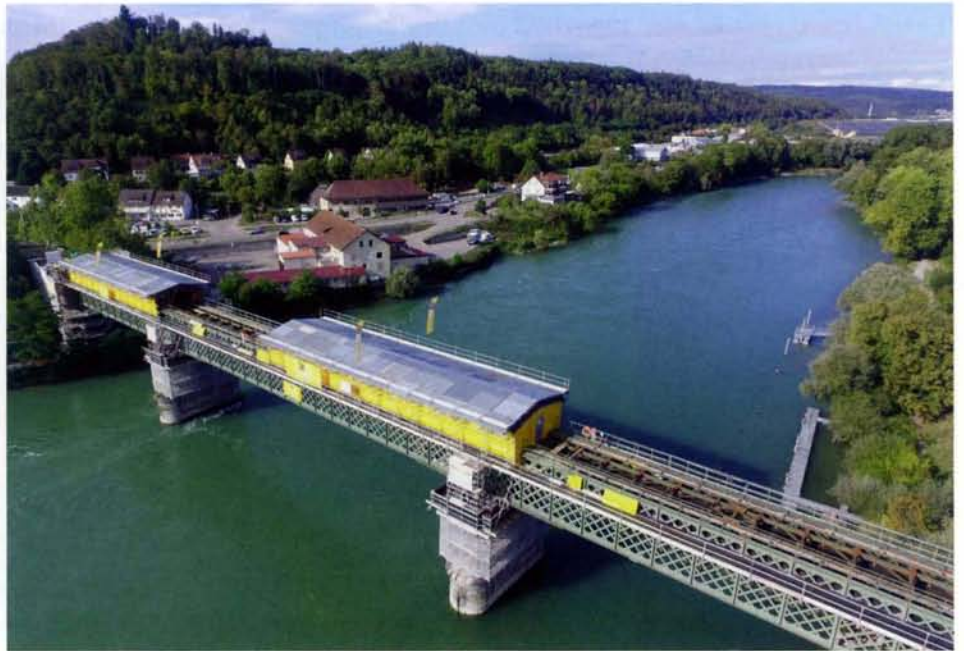
Drohnenaufnahme der Rheinbrücke Koblenz am 16.9.2023, die umfassend instandgesetzt wird. Foto: J. D. Lüthard
