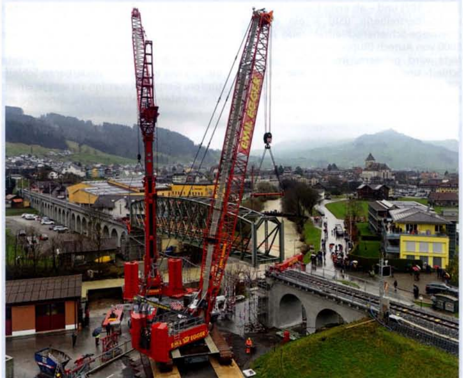
Die revidierte Brücke beim Absenken auf die Widerlager am 29.3.2025. Drohnenaufnahme. Foto: J. D. Lüthard
