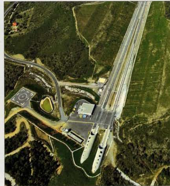
Die beiden Nordportale des 8,2 Kilometer langen Pertús-Tunnels bei La Boulou. Aufn.: F. Hédelin, TP Ferro
