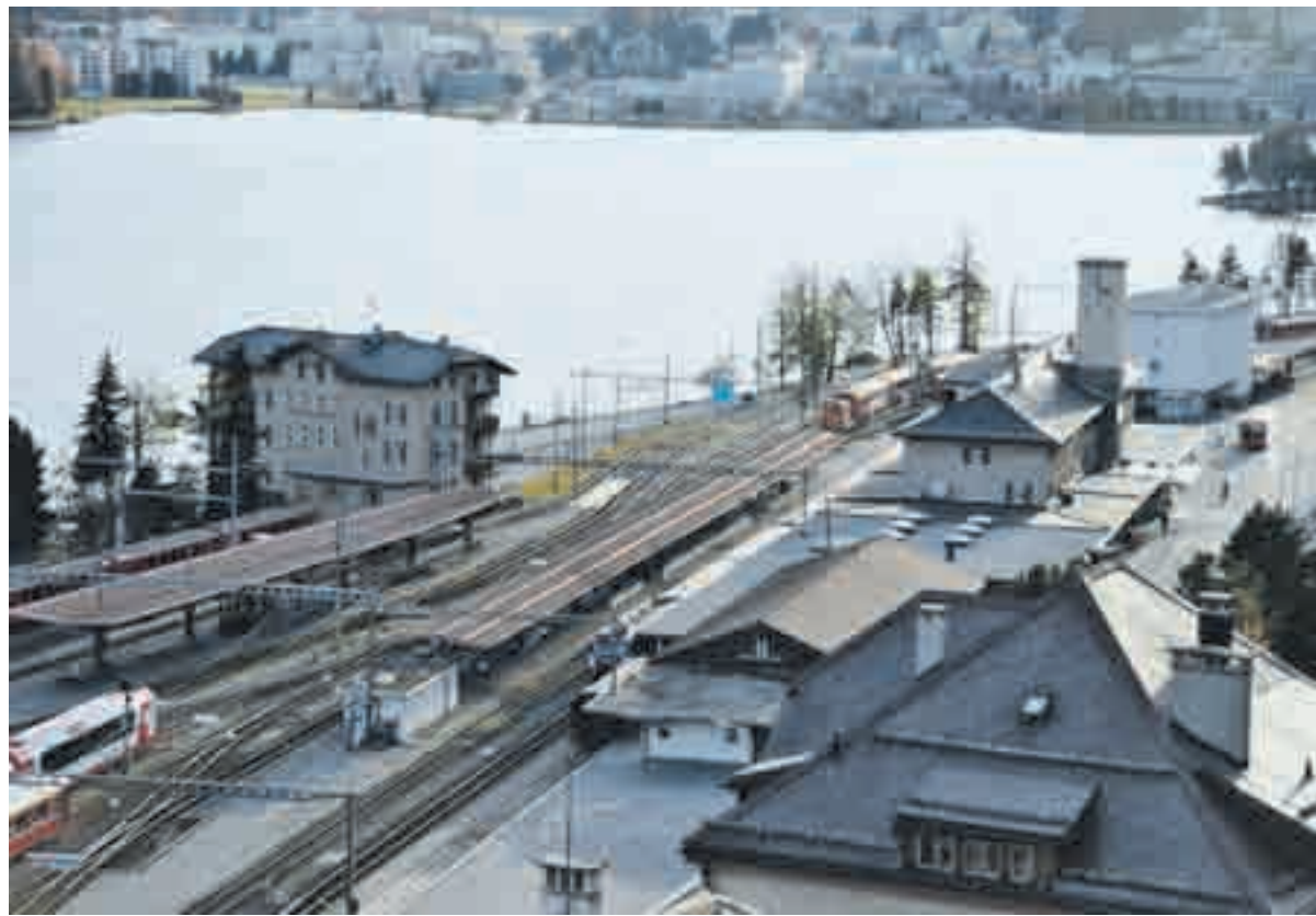
Der Bahnhof St. Moritz soll erneuert werden. Die heutigen Gleis- und Sicherungsanlagen weisen grosse Sicherheitslücken auf. Foto: Reto Stifel
