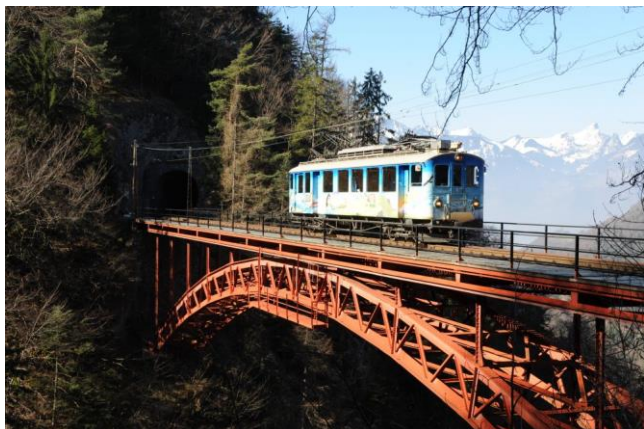
Der BDe 4/4 1 auf seiner letzten Fahrt im Fantasieanstrich auf dem schwer zugänglichen 76 Meter langen Vanex Viadukt. (Foto: J. Lüthard, 12.03.2014)
