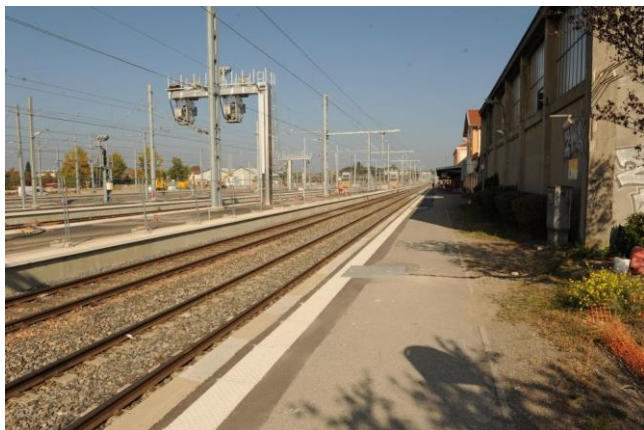
Mit Gittern ist alles weiträumig abgesperrt. (Foto: J. Lüthard, 10.10.2018)
