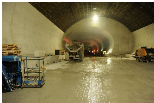
Abzweigung Haupttunnel – Verbindungstunnel, Blickrichtung Umfahrungstunnel Innsbruck, welcher ab hier zweigleisig erreicht wird. (Foto: J. Lüthard, 05.06.2019)
