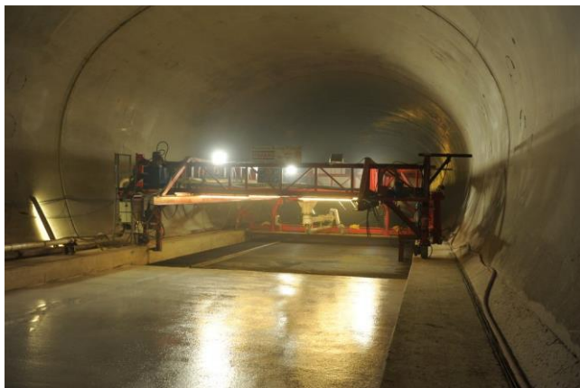
Betonierung der Sole im Überführungsbauwerk. Anschliessen kommt in die Mitte eine 45 cm dicke Betonwand zur Trennung von Bahntrasse und Rettungsweg zu stehen. (Foto: J. Lüthard, 05.06.2019)
