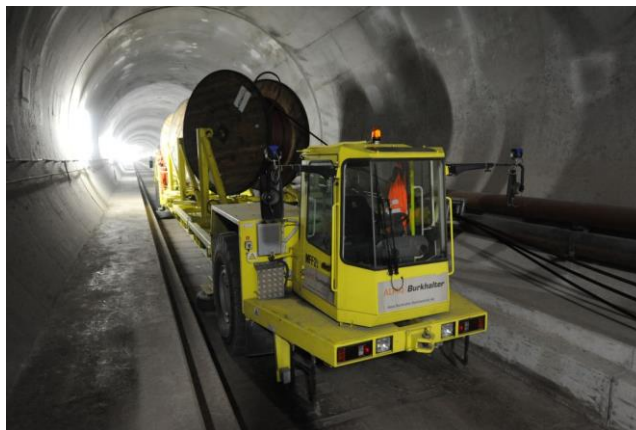
Das MFF in der Oströhre beim Einzug von 50 Hz Starkstromkabeln ab drei Bobinen. (Foto: J. Lüthard, 31.10.2013)
