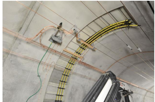
Die sich im Bau befindende Einspeisestelle Amsteg in der Weströhre. (Foto: J. Lüthard, 31.10.2013)
