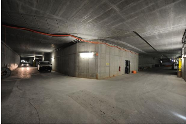
Multifunktionsstelle Faido, nach links Zugangsstollen zur Nothaltestelle in der Weströhre, nach rechts der Zugangsstollen mit 13 % Steigung nach Faido. (Foto: J. Lüthard, 31.10.2013)
