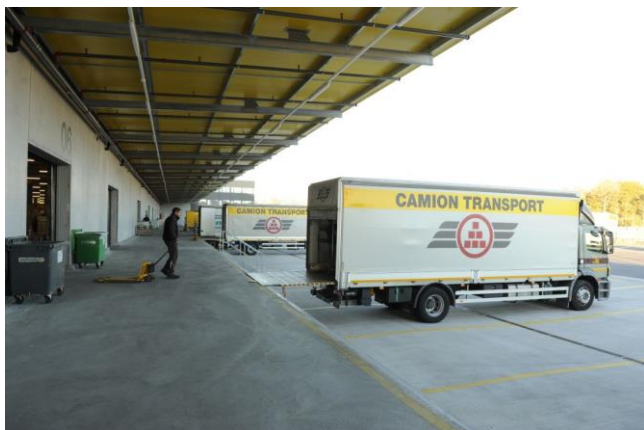
Ein Teil der 51 Rampenplätze am Center «Léman». (Foto: J. Lüthard, 25.10.2018)
