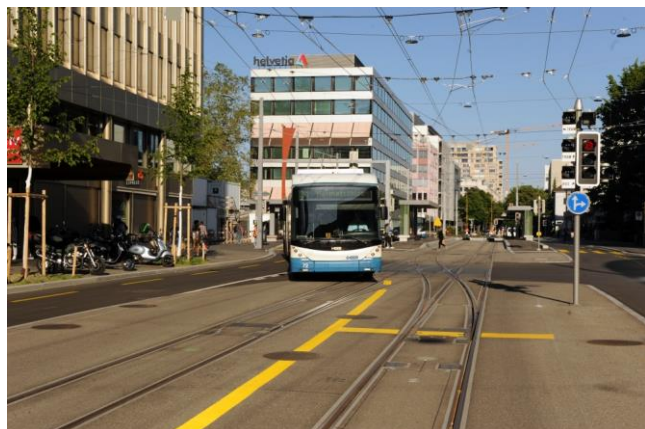
Die zukünftige Endhaltestelle der LTB vor dem Bahnhof Altstetten. Im Hintergrund sind die zwei Prellböcke erkennbar und in Vordergrund die Weichen des doppelten Gleiswechsels. Links der Trolleybus der Linie 31 der nach der Bushaltestelle auf das Tramtrasse wechselt. (Foto: J. Lüthard, 31.05.2021)
