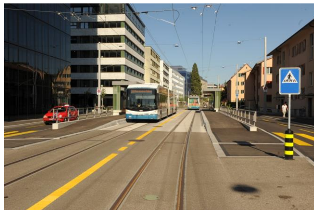
Mit Blickrichtung Bahnhof Altstetten die Haltestelle Seidelhof. (Foto: J. Lüthard, 31.05.2021)
