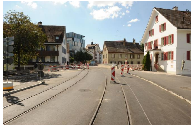
Mit Blick in Richtung Baden in der Bildmitte die Reppischbrücke. Im Hintergrund ist das Gebäude erkennbar in welchem bis 1924 die Brauerei Löwenbräu bestand. Hier war zwischen 1900 und 1928 die Endstation der Limmattal Strassenbahn (LSB) welche mit Güterwagen das Bier in die Stadt Zürich brachte. Am ockerfarbigen Gebäude in der Mitte ist noch ein Mauerhacken der LSB vorhanden. (Foto: J. Lüthard, 15.08.2020)
