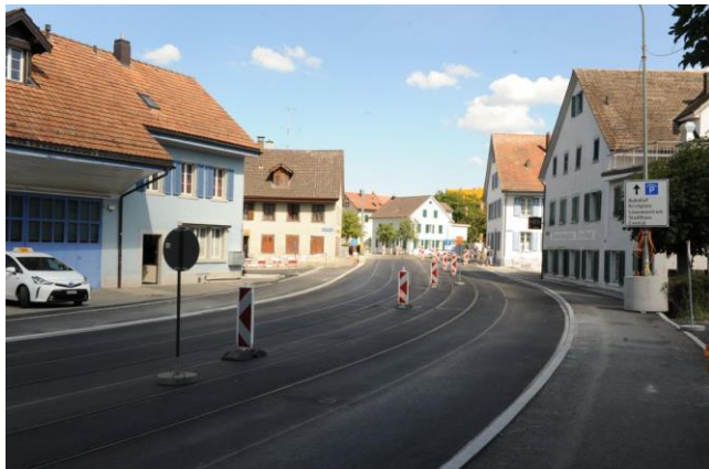
Mit Blickrichtung Zürich, die nun erstellte «Dorfdurchfahrt» in Dietikon. In der Bildmitte die Reppischbrücke. Das Ganze wirkt sehr ländlich und schon fast idyllisch. Aber es dauert noch über ein Jahr bis die erste Bahn hier verkehrt. (Foto: J. Lüthard, 15.08.2020)
