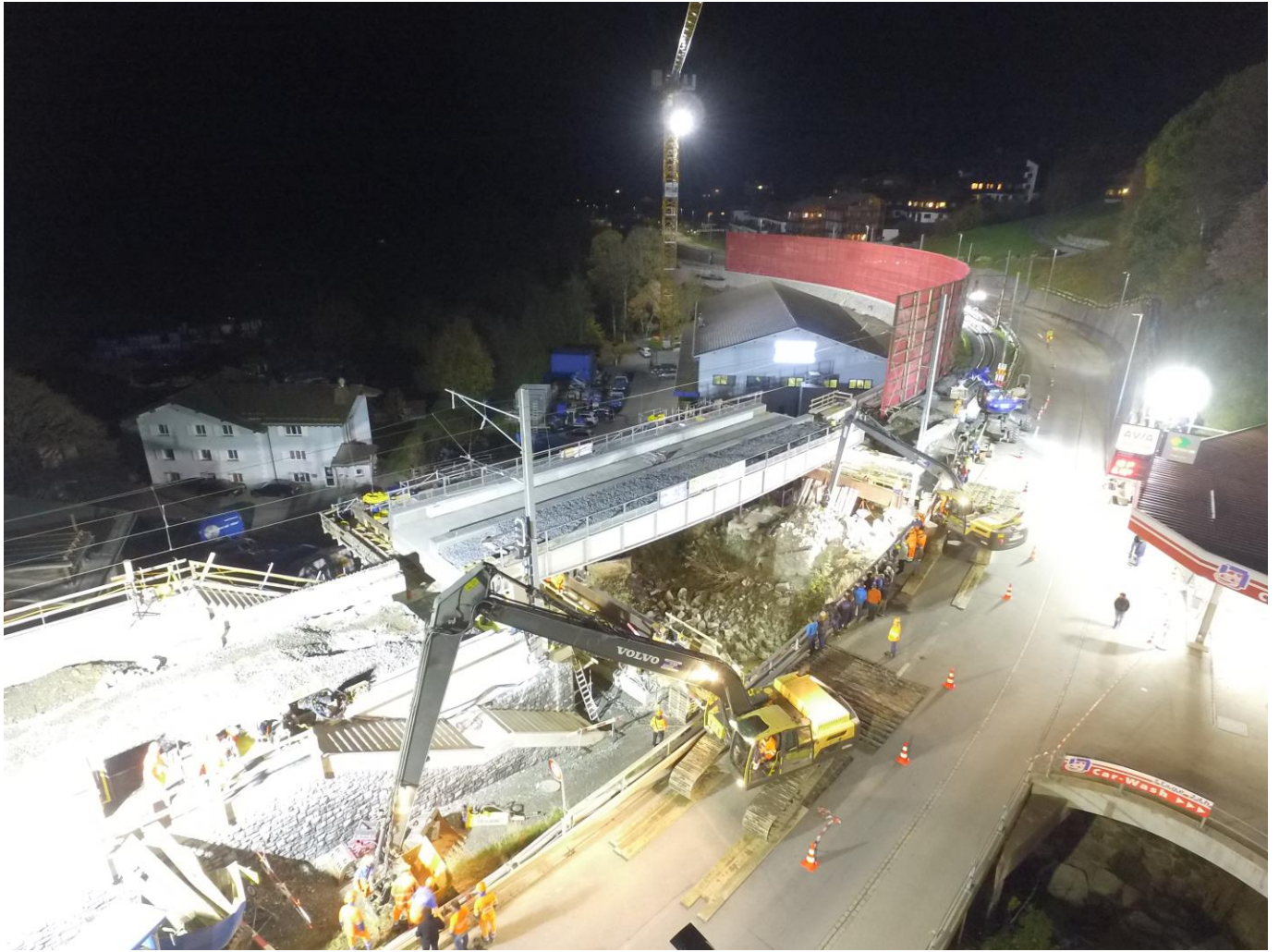
Vorne links: die talseitig verlängerten Bahnsteigenden von Klosters Dorf. In der Mitte: die neue Brücke während des Einschubes bei gleichzeitigem Abbruch der alten Wiederlager durch die beiden Bagger mit ihren Abbruchhämmern. Hinten die neue Stützmauer für die zukünftige Doppelspur. (Foto: J. Lüthard, 15.10.2022 um 22:35)
