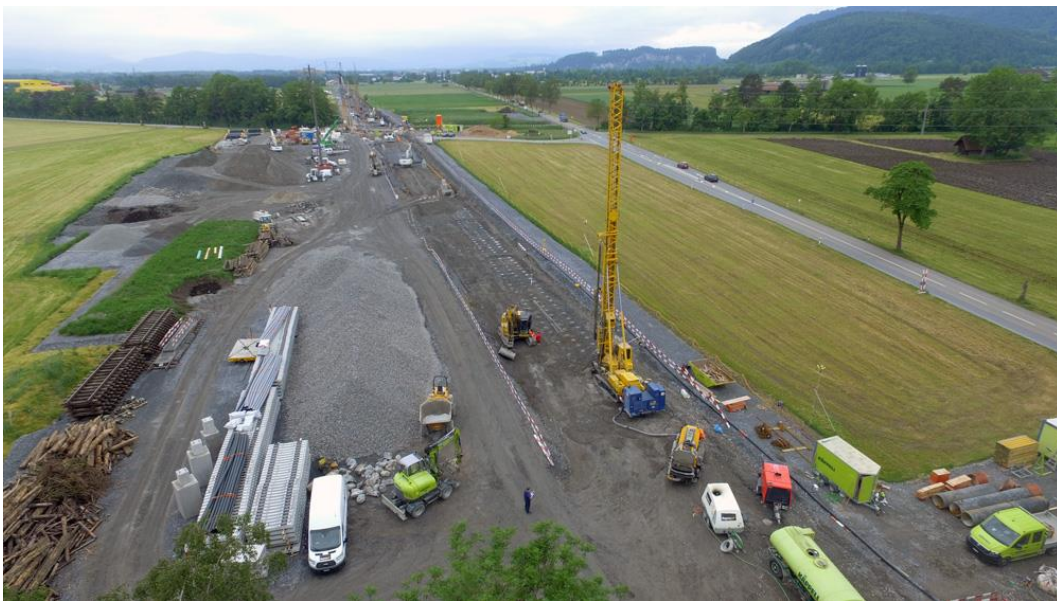
Nördlich von Oberriet mit Blickrichtung nach Süden, links eines der Zwischenlager, in der Mitte ein Mäkler und rechts die Staatsstrasse. Im Hintergrund die unterbrochene Altstätterstrasse sowie der neue Durchlass für den Dürrenbach. Im Zwischenlager erkennbar die alten Gleisjoche und Holzpfähle sowie drei vorgefertigte Mastfundamente, die neuen Betonschwellen und das Schotterlager. Im Hintergrund liegt diverses Füllmaterial bereit. (Foto: J. Lüthard, 24.05.2023)
