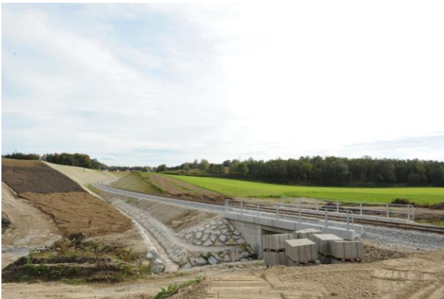
Die grössten Erdbauarbeiten waren zwischen Trimmelkam und der neuen Haltestelle Diepoltsdorf erforderlich. Im Vordergrund die Brücke über den Hollersbach. Blickrichtung Trimmelkam, unmittelbar vor der Haltestelle Diepoltsdorf. (Foto: J. Lüthard, 15.10.2014)
