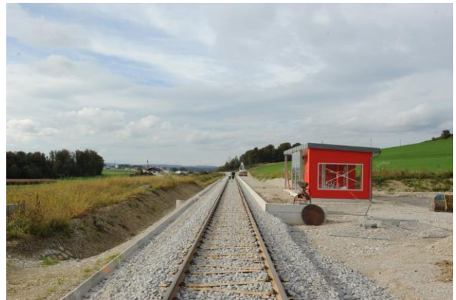
Die fast fertig erstellte Haltestelle Diepoltsdorf. Blickrichtung Ostermiething. (Foto: J. Lüthard, 15.10.2014)
