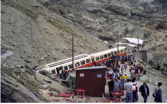
Nach einem kurzen Tunnel endet die Bahn noch heute mitten in einer Felswand. Die touristische Infrastruktur in Nid d'Aigle war in den 1980er Jahren sehr bescheiden. Das «kulinarische» Angebot an der Baracke war übersichtlich. Ein WC gab es nirgends. Die meisten Fahrgäste sind nach wenigen Minuten gleich wieder in denselben Zug zur Rückfahrt eingestiegen. Heute entspricht die Infrastruktur eher den Erwartungen. (Foto: J. Lüthard, 16.07.1982)
