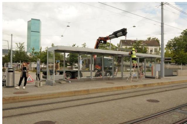
Der letzte Trog wird auf das Dach montiert. Im Hintergrund der Prime Tower. (Foto: J. Lüthard, 26.08.2021)
