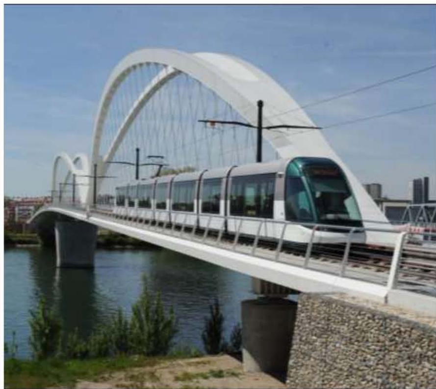
Seit der Einweihung der neuen Verbindung über den Rhein am 28. April 2017 verkehren wieder Straßenbahnen zwischen Straßburg und Kehl. Im Bild eine Tram beim Verlassen der spektakulären Rheinbrücke in Richtung Kehl. Foto: Jürg D. Lüthard.
