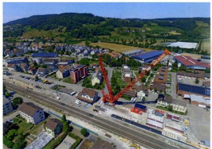
Pfungen: der schweizweit grösste Raupenkran dominiert den Bahnhof.
