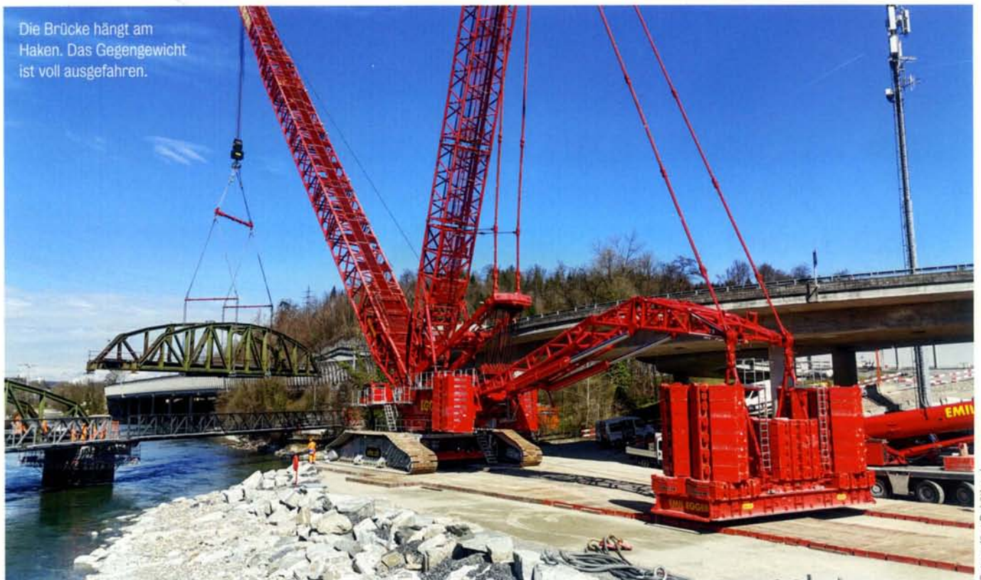
Kurz vor dem Hub des ersten Brückenbogens aus dem Jahre 1921.
