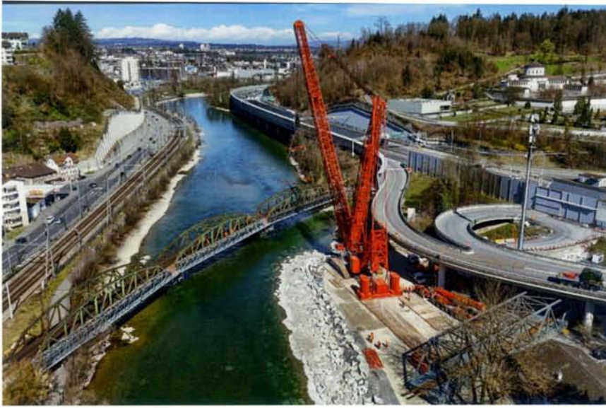
Die Situation um die Fluhrmühlebrücke über die Reuss: links die Strecke Luzern–Emmenbrücke, in der Bildmitte der schweizweit grösste Raupenkran und rechts die Autobahn A2.
