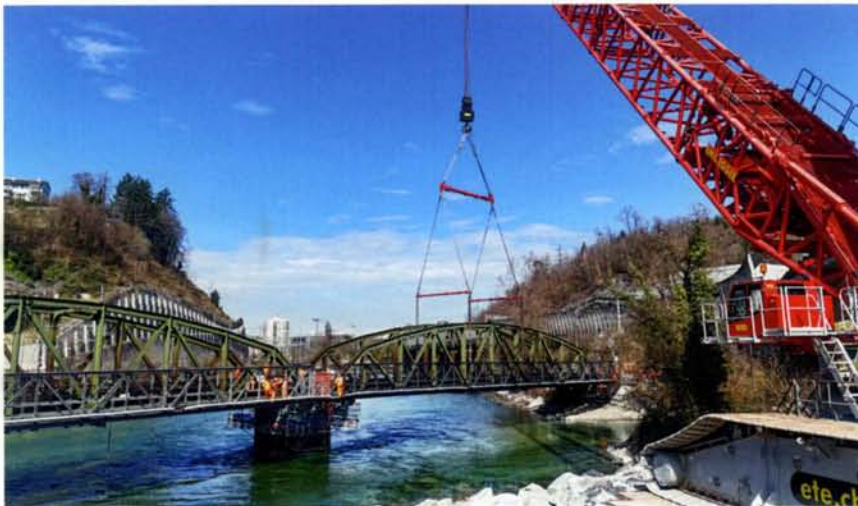
Kurz vor dem Hub des ersten Brückenbogens aus dem Jahre 1921.
