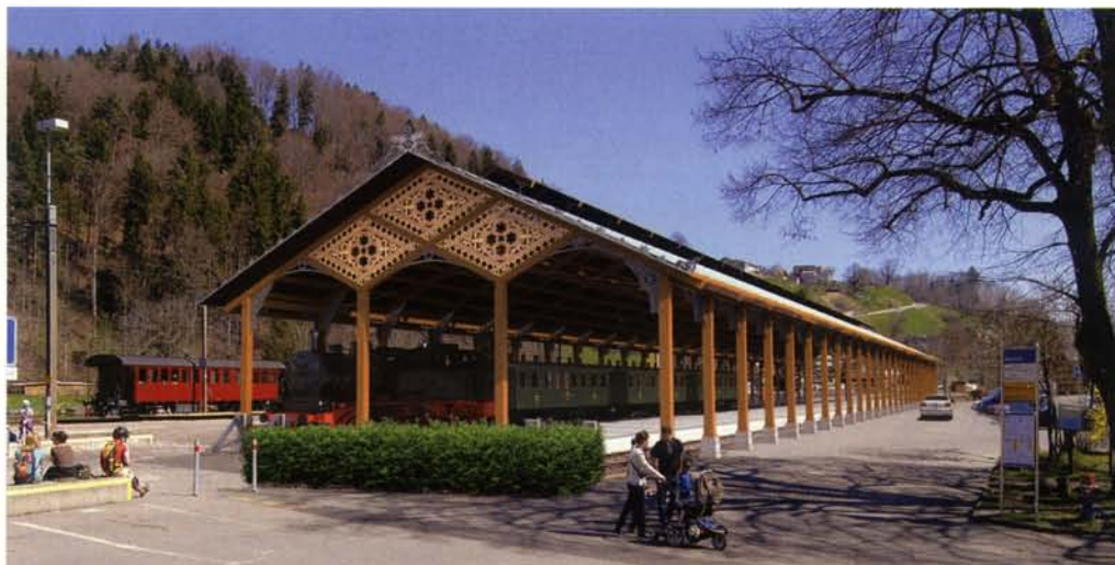
Nach dem Umzug wird die historische Baseler Bahnhofshalle Reisenden auf dem Bahnhof in Bauma Schutz bieten.
