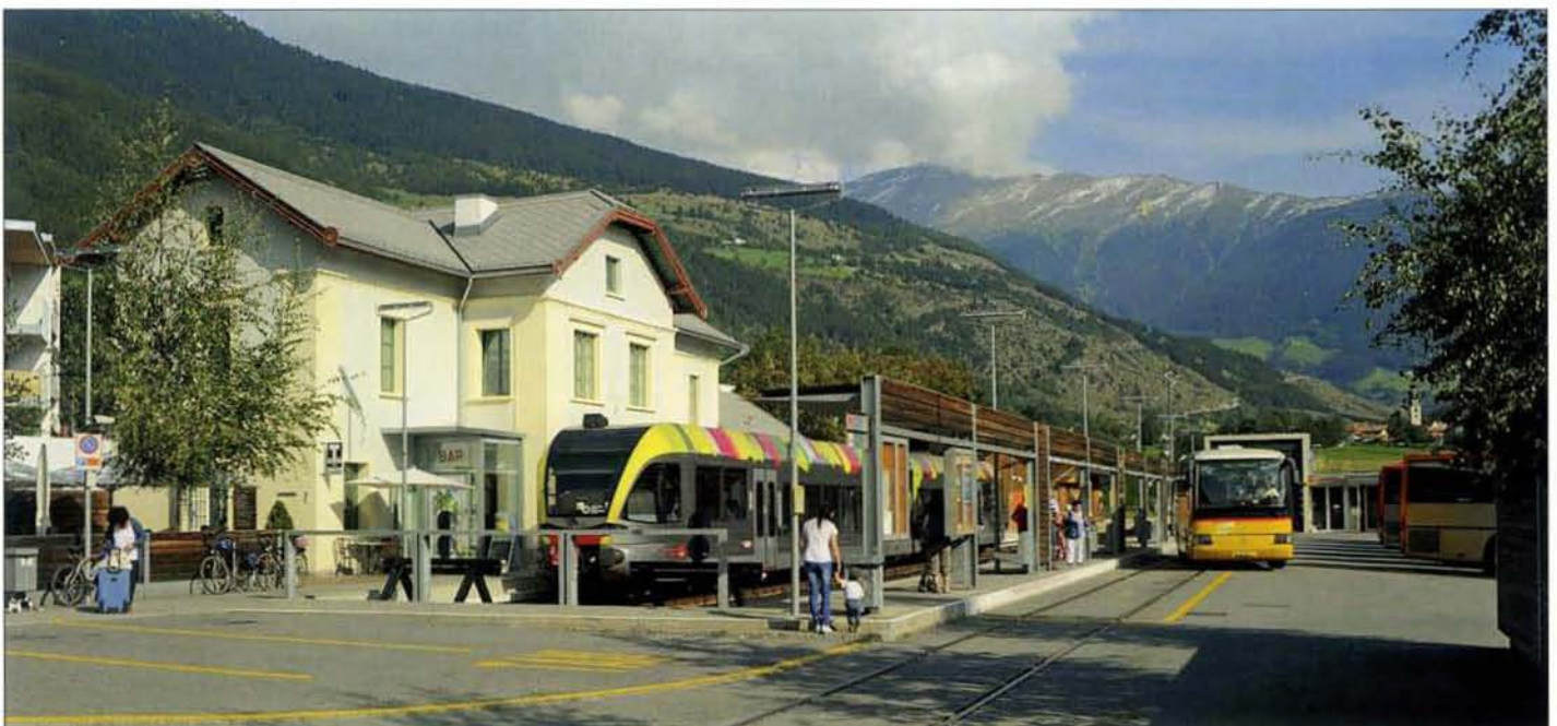
Der Endbahnhof Mals bietet ideale Umsteigebeziehungen zu den diversen Autobuslinien, hier rechts das Postauto nach dem 50 km entfernten Zernez. Die Gleise im Vordergrund sind Bestandteil des denkmalgeschützten Wende-Fünfecks. Im Bahnhofsgelände befindet sich ein Restaurant, im ehemaligen Güterschuppen eine Touristeninformation und dahinter ein sehr beachtlich großer Veloverleih.
