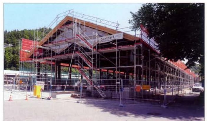
Die fast fertiggestellte 100 m lange Halle im Bahnhofsareal Bauma.
