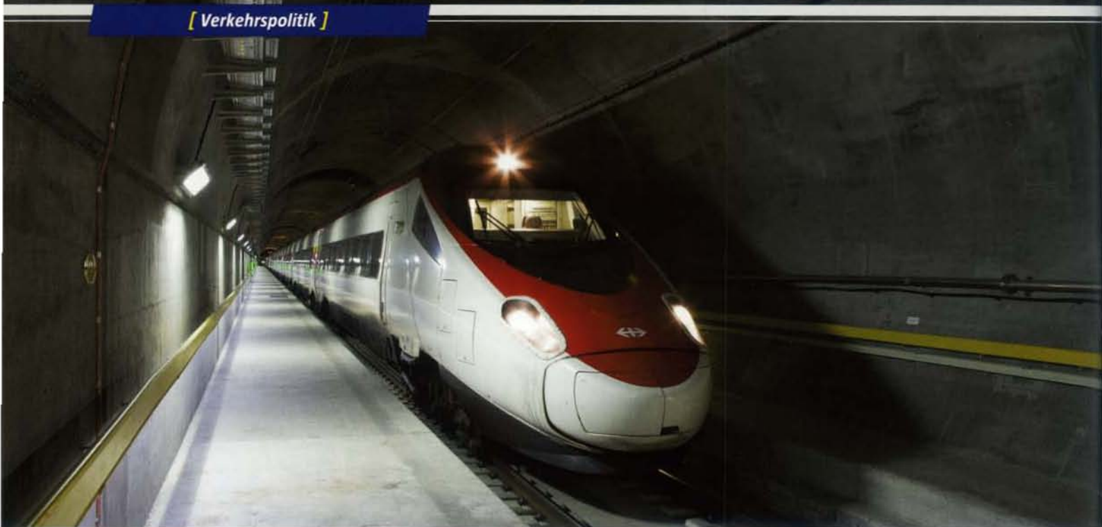
Gothardzug ETR 610 von Alstom im neuen Tunnel.
