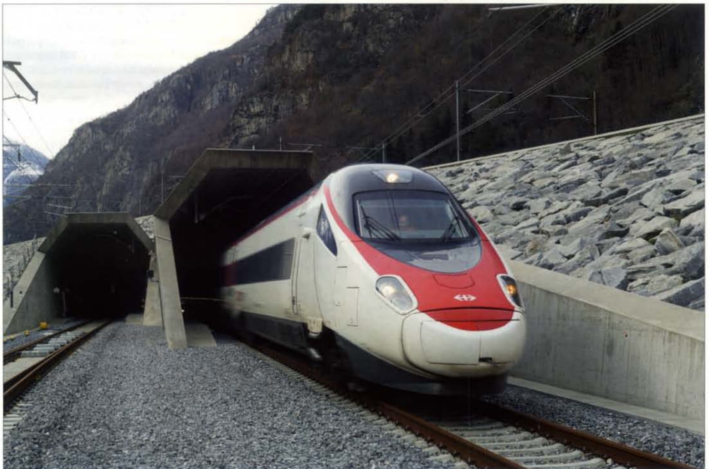
Ausfahrt aus dem Gotthard-Basistunnel.
