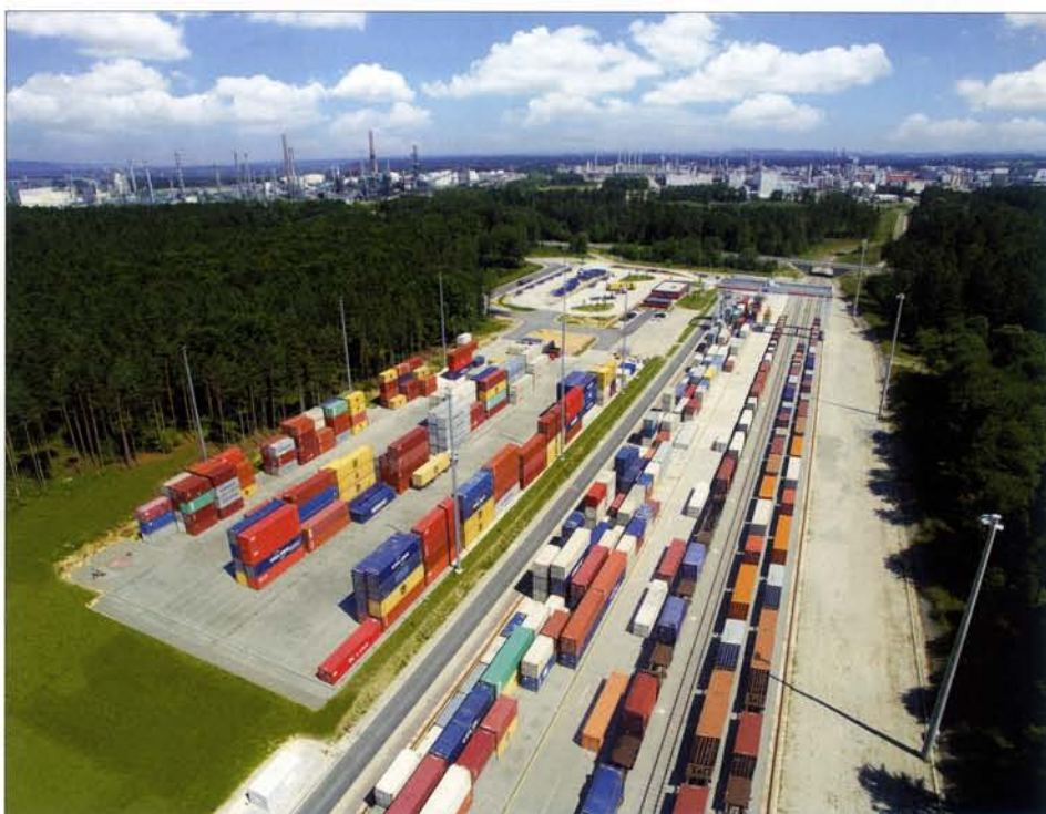
Leercontainerlager; Mitte oben: Parkplatz und Bürogebäude; Hintergrund: Industriegebiet von Burghausen; ganz rechts: vorgesehener Platz für ein Umfahrgleis und zwei Abstellgleise.
