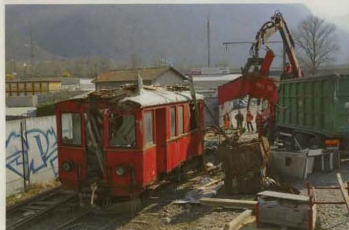
Am 22. März wurde in Castione auf dem einstigen Streckengleis der 102 Jahre alte ABde 4/4 454 der Misoxyerlinie abgebrochen (Foto: T. Keller).
