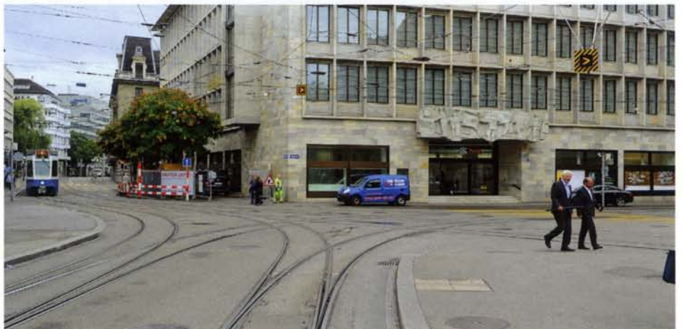
Unten: Die Situation am Paradeplatz: nach links der Fahrweg der Linie 8, nach rechts jener der Linien 2 und 9. Am rechten Bildrand erkennt man das schon bisher vorhandene, in der Bildmitte das zusätzlich angebrachte Weichensignal (Foto: J. Lüthard, 18. September 2013).
