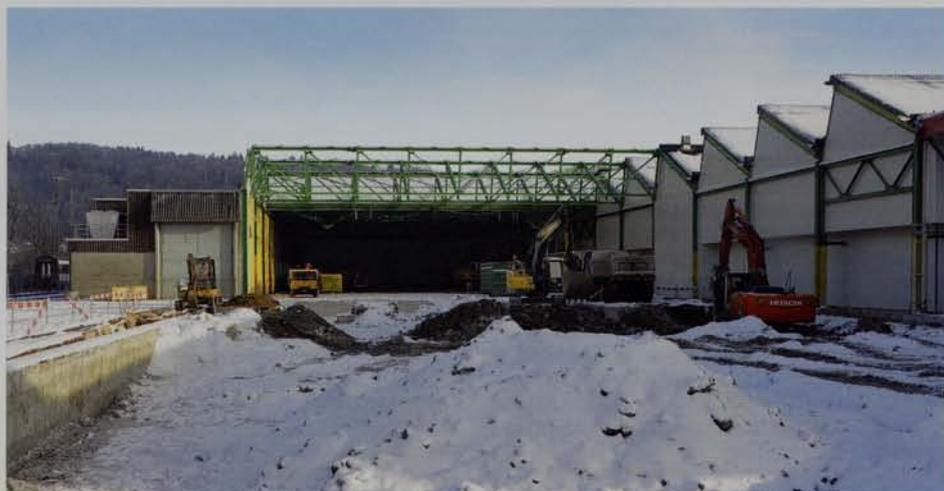
Oben: Blick auf den bereits weitgehend abgerissenen Westteil der Wagenhalle Tannwald; hier entsteht die neue, vier Meter höhere Halle mit den drei 150 Meter langen Revisionsgleisen. Eine temporäre Bauwand (rechts) schliesst den vom Umbau nicht betroffenen Bereich der Halle nach aussen hin ab (Foto: M. Rellstab, 17. Januar 2017).
