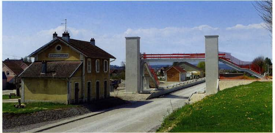
Oben: Im künftigen Bahnhof Grandvillars verbindet, wie in Delle, eine Überführung mit Treppen und Aufzügen die beiden Perrons (Foto: K. Woker, 5. April 2017).
