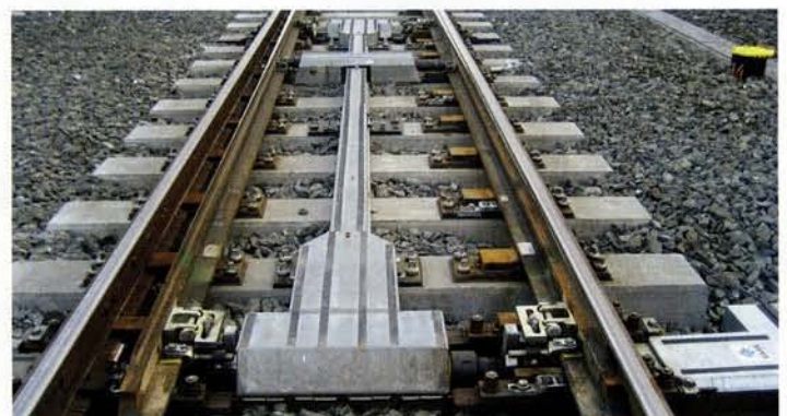
Innenliegendes Kraftübertragungsgestänge PGS mit Verschluss-system „Sperlock“ und in die Schwelle integriertem Weichenantrieb „Ecostar“ (Foto: Voestalpine).
