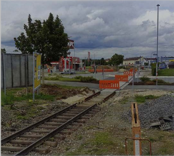
Links: Der Kreisverkehr im Singener Industriegebiet mit dem in Betontragplatten verlegten, wieder eingesetzten Gleisstück, das zum Aufnahmezeitpunkt allerdings noch nicht mit den beiden Enden des Streckengleises verbunden war (Foto: M. Will, 19. August 2019).
