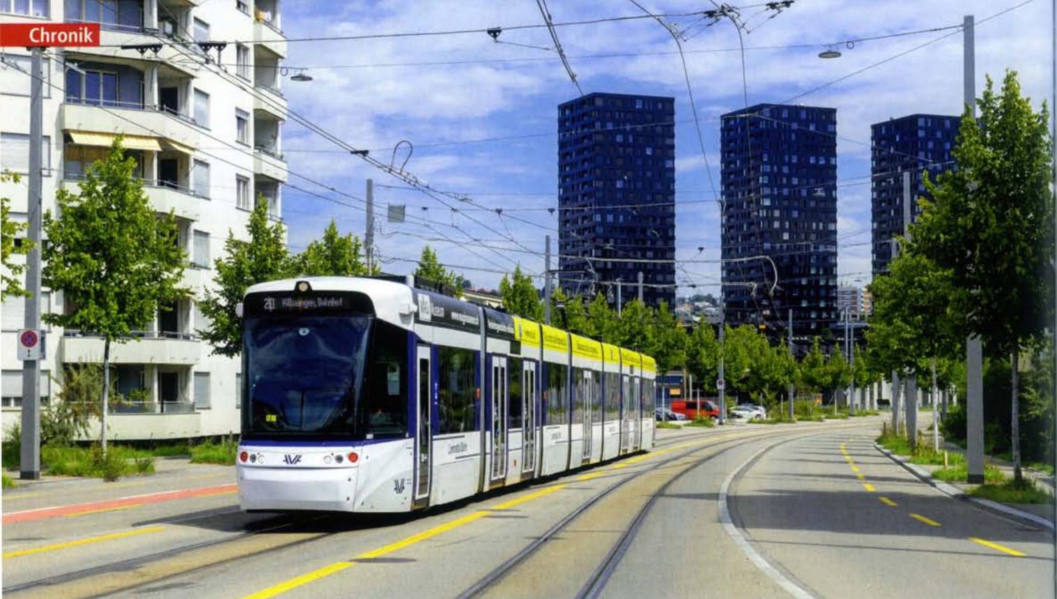
Schwere Verkehrsunfälle und langwierige Reparaturen sorgen auf der Limmattal-Bahn bei Zürich für Schwierigkeiten bei der Aufrechterhaltung des Betriebs. Am 5. August ist Tw 8001 auf der Hohlstrasse unterwegs von Altstetten zur Kreuzung Farbhof MICHAEL BEITELSMANN
