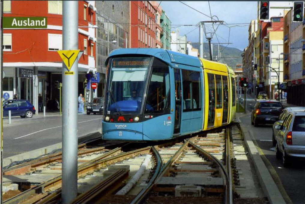
Der doppelte Gleiswechsel nach der Endstation Trinidad wurde nachträglich eingebaut und ersetzt zwei einfache Gleiswechsel. Tw 11 trägt vorne die Nummer »11«, an den Segmenten die »111«
