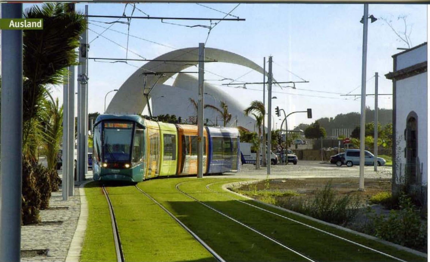
Kurz nach dem Verlassen der Endstation Intercambiador beginnt ein erster Rasengleisabschnitt. Im Hintergrund spannt sich das 2003 eröffnete neue Wahrzeichen von Santa Cruz de Tenerife, das von Santiago Calatrava errichtete Auditorio de Tenerife
