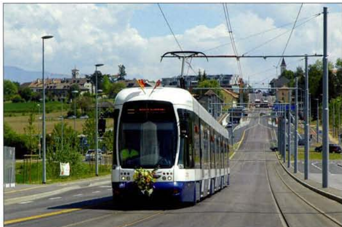
Während die Tram den auf einem Hügel gelegenen Ortskern von Meyrin oberirdisch durchquert, wird der Durchgangs-IV im Tunnel geführt (Rampen sichtbar).
