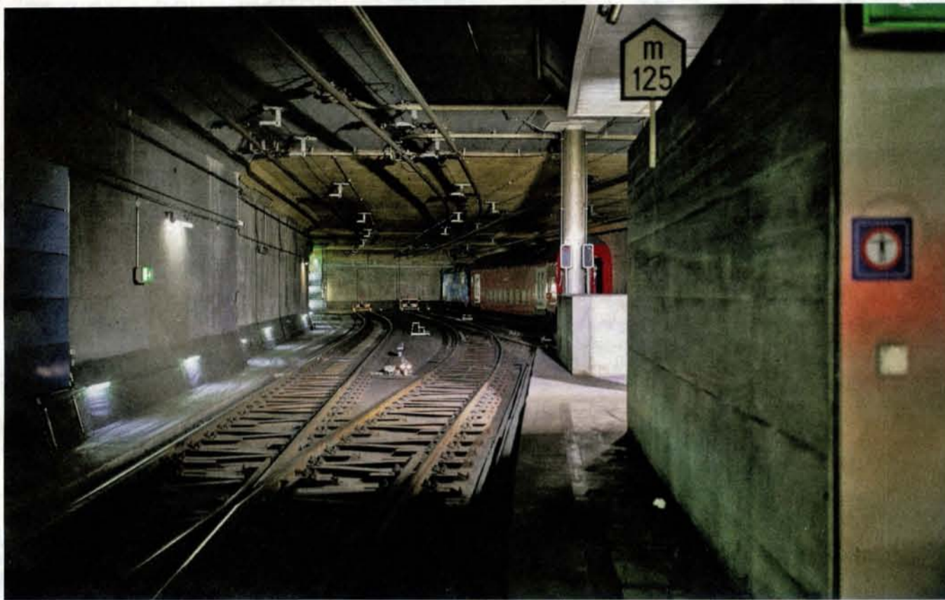
Der Tunnelstummel unter dem Shopville, ausnahmsweise mal gut ausgeleuchtet. Foto: Fabienne Andreoli
