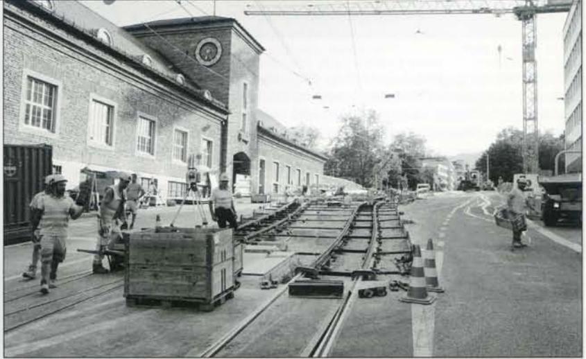
Am 14. August 2021 werden auf der neuen Brückenhälfte die Gleise gelegt. Photo: Jürg D. Lüthard
