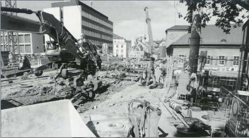
Die Abbrucharbeiten vom 10. Juli 2021 an der Bederbrücke (siehe Tram 147 auf Seite 35) waren sehr spektakulär. Rechts sehen wir den Bahnhof Enge. Photo: Jürg D. Lüthard
