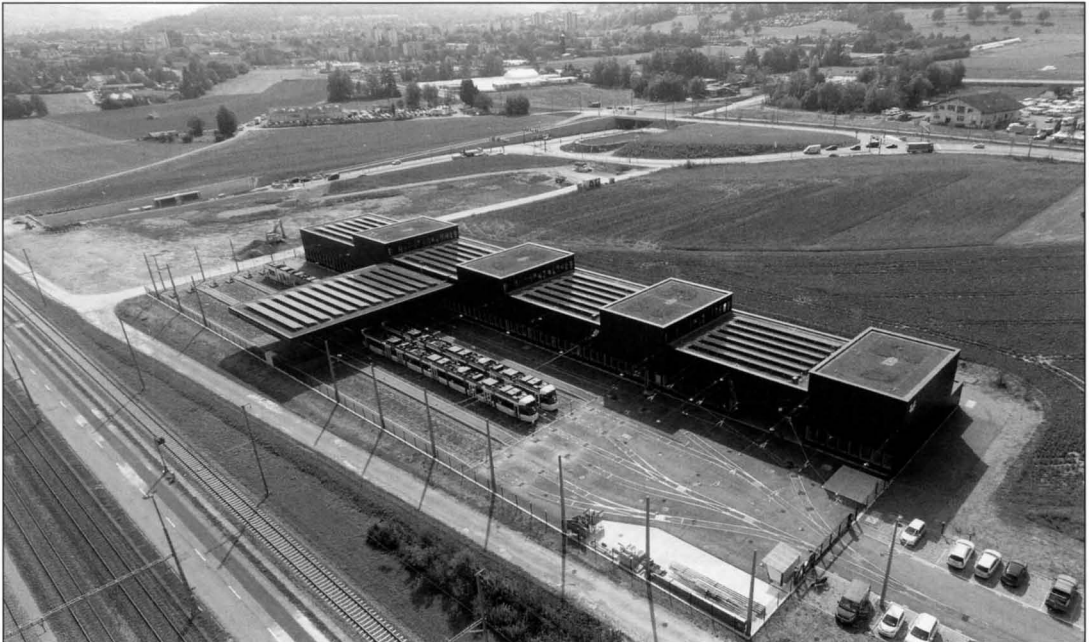
Das Depot Müsli der Limmattalbahn am 23. September 2022 von oben. Unverständlicherweise sind die Abstellgleise nicht überdacht und die Züge damit der Witterung ausgesetzt. Photo: Jürg D. Lüthard
