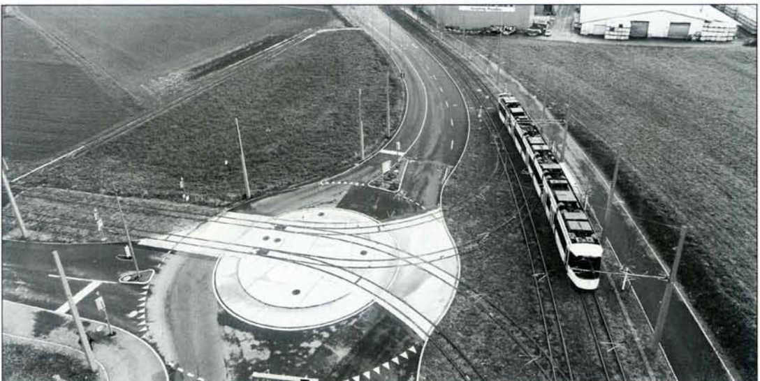
Der Abzweig zum Depot Müsli ist als doppelgleisiges Gleisdreieck konzipiert, die restliche lange Zufahrt erfolgt dann ein-gleisig. Diese Drohnenaufnahme von Jürg D. Lüthard entstand am 31. Dezember 2022.
