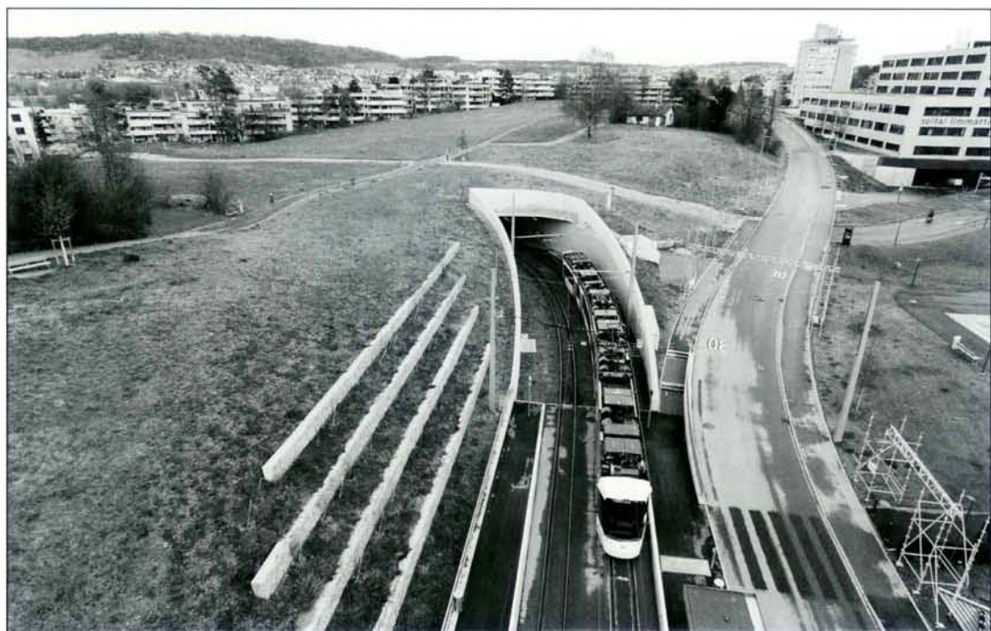
Portal des Färberhüslitunnel, Seite Spital Limmattal: Ein aus Killwangen kommender Tramlink fährt am 31. Dezember 2022 in den 245 Meter langen Tunnel auf Schlieremer Boden. Photo: Jürg D. Lüthard
