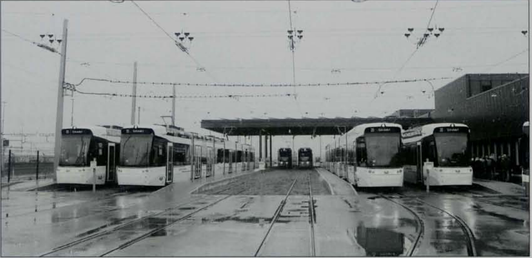
Die sieben Abstellgleise im Freigelände des Depots Müsli bieten für je zwei Wagen Platz. Im 145 Meter langen, 24 Meter breiten und 11 Meter hohen Gebäude befinden sich zwei Gleise, eines mit Waschanlage und eines für den Unterhalt mit Grube und Bühnen. Von links nach rechts sehen wir die Be 6/8 8004, 8007, 8003, 8005, 8001 und 8002, die am 9. Dezember 2022 starken Regenfällen ausgesetzt waren. Photo: Martin Senft
