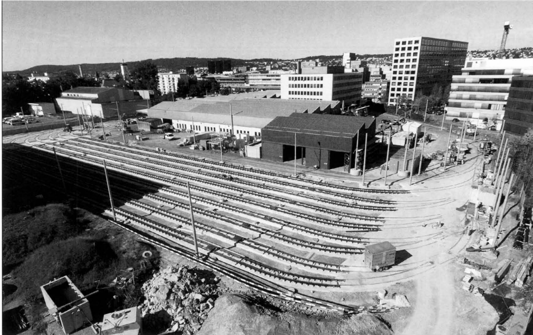
Die in Lieferung befindlichen 110 Flexitys sind insgesamt rund 1,77 km länger als die bis 2027 auszurangierten Tram 2000. Um der Platznot abzuwehren, bauen die VBZ seit dem 5. November 2022 südlich ihres Verwaltungs- und Betriebsgebäude in Altstetten eine neungleisige Abstellanlage für 23 Flexitys. Das Bild von Jürg D. Lüthard entstand am 25. September 2023.
